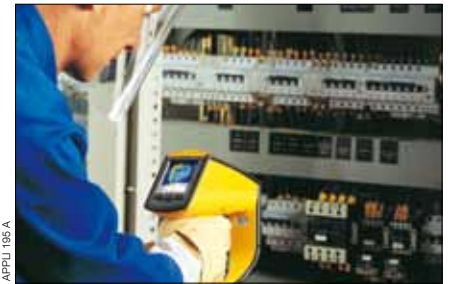
Inspectie van de schakelkast
